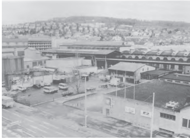
Abb. 33: Grundstück für das Kraftwerk1 auf dem Escher-Wyss-Areal (Blum, Hofer et al. 1993: 78)
