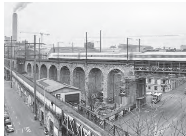
Abb. 83: Viaduktbögen vor Baubeginn 2008 (www.em2n.ch. Zugriff am 04.08.14)
