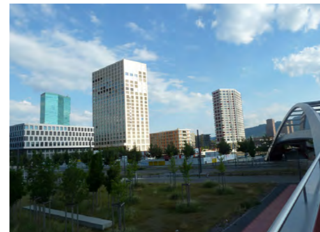
Abb. 78: Die Passerelle verbindet Westpark und Pflingstweidpark (Eigenes Foto 2014)
