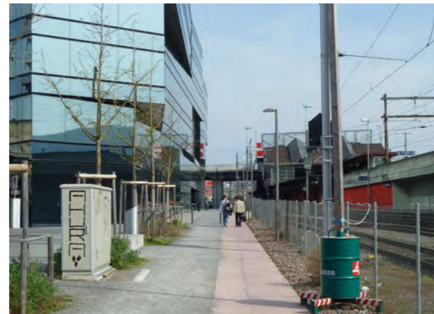
Abb. 62: Gleisbogen in Richtung Bahnhof Hardbrücke (Eigenes Foto 2014)
