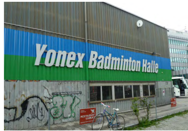
Abb. 176: Badmintonhalle (Eigenes Foto 2012)
