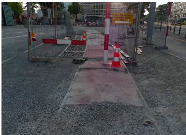
Abb. 59: Gleisbogen im Bau (Eigenes Foto 2010)
