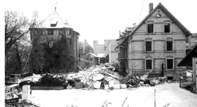
Abb. 126: Abbruch Schöller (BAZ, 1996, Baugeschichtliches Archiv der Stadt Zürich)
