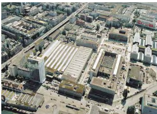
Abb. 47: Luftbild Sulzer - Escher - Wyss (Allreal / Ralph Bensberg In: Hochparterre 2005)
