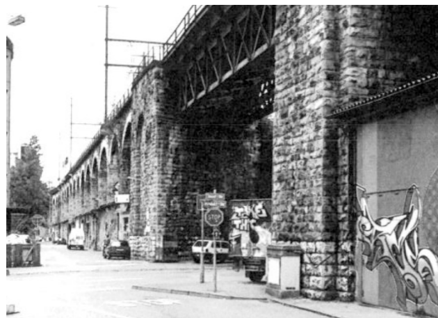
Abb. 81: Viaduktbögen mit Zwischennutzung (BAZ 2003, Baugeschichtliches Archiv der Stadt Zürich)
