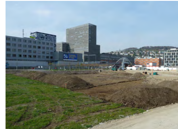
Abb. 76: Beginn der Bauarbeiten (Eigenes Foto 2014)
